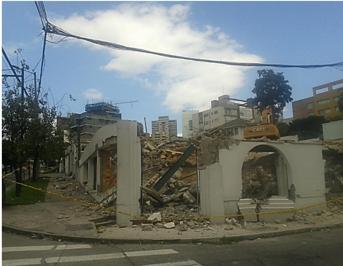
Derrocamiento en Av. Orellana y San Javier: retroexcavadora en acción, ninguna recuperación de materiales. Fuente: foto tomada el 4 de abril de 2017 (Cabezas I., 2017)
